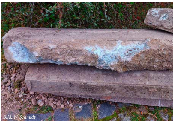
Ausgebaute Bordsteine mit soliden Betonanhaftungen; Bild: W. Schmidt
