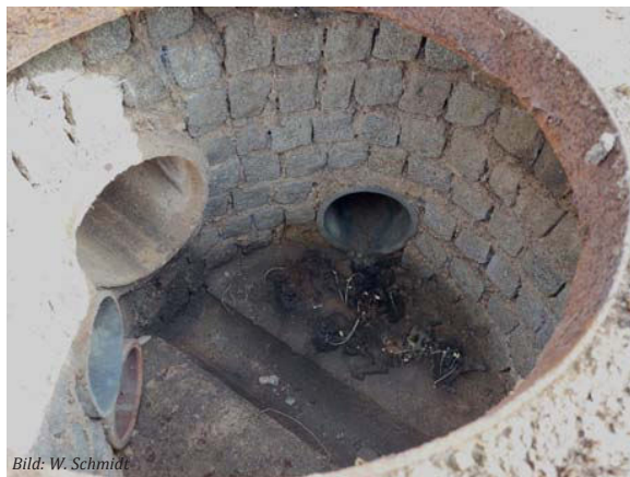
Die gemauerten Abwasserschächte mit Zuflüssen für alle Eventualitäten; Bild: W. Schmidt
